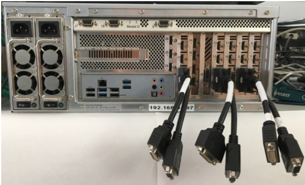
Fig.: Installed Y cable
